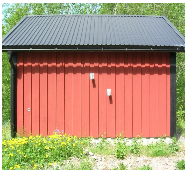
Utanför tryckstegringsstationen leds våluft ut och man tar in regenereringsluft
